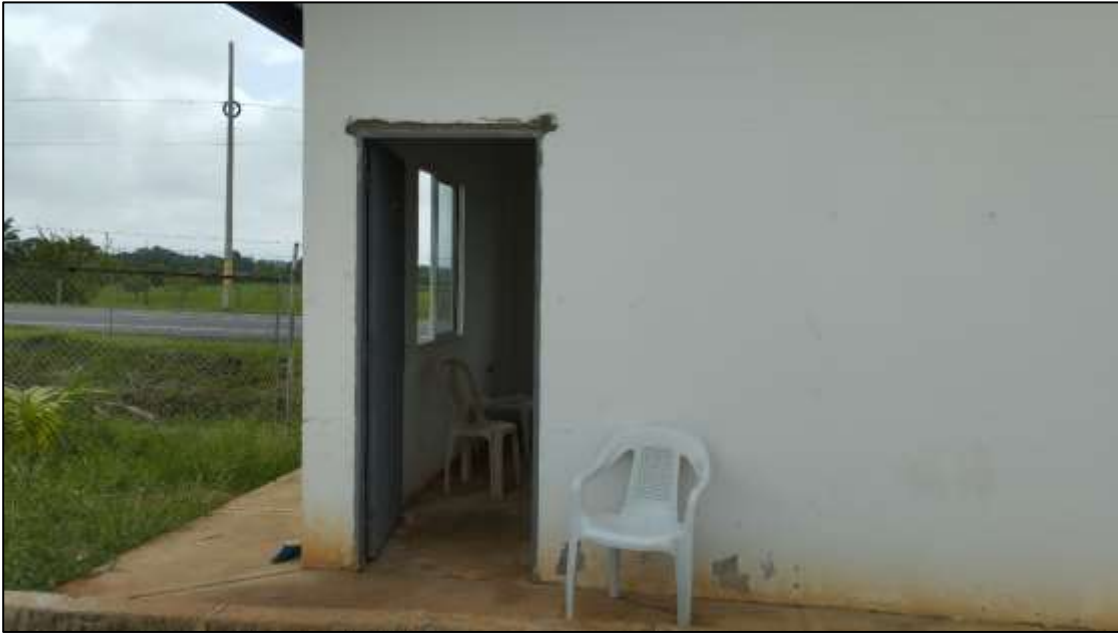
Portería de acceso a la planta con puerta y ventana instalada
