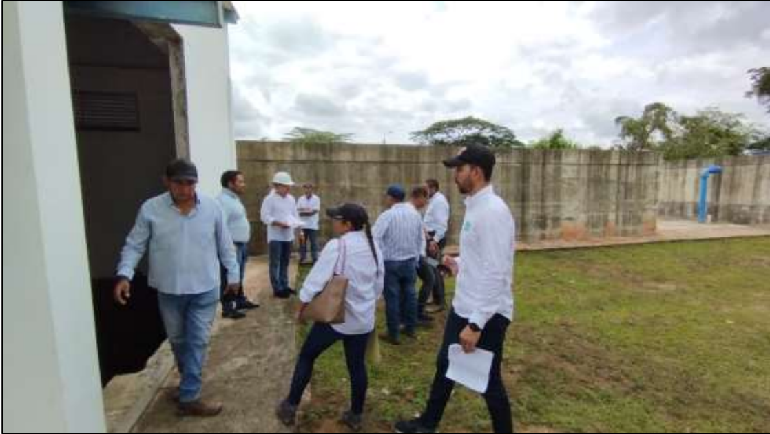
Comisión técnica revisando los tanques y los 2 cuartos de bombas de la Estación de bombeo de Buena Vista hacia Planeta Rica
