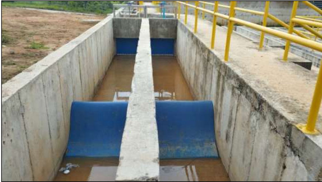
Vertederos de la etapa de coagulación ya terminados y funcionales
