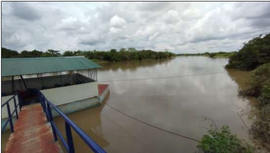
Barcaza donde está la captación y el equipo de bombeo inicial
