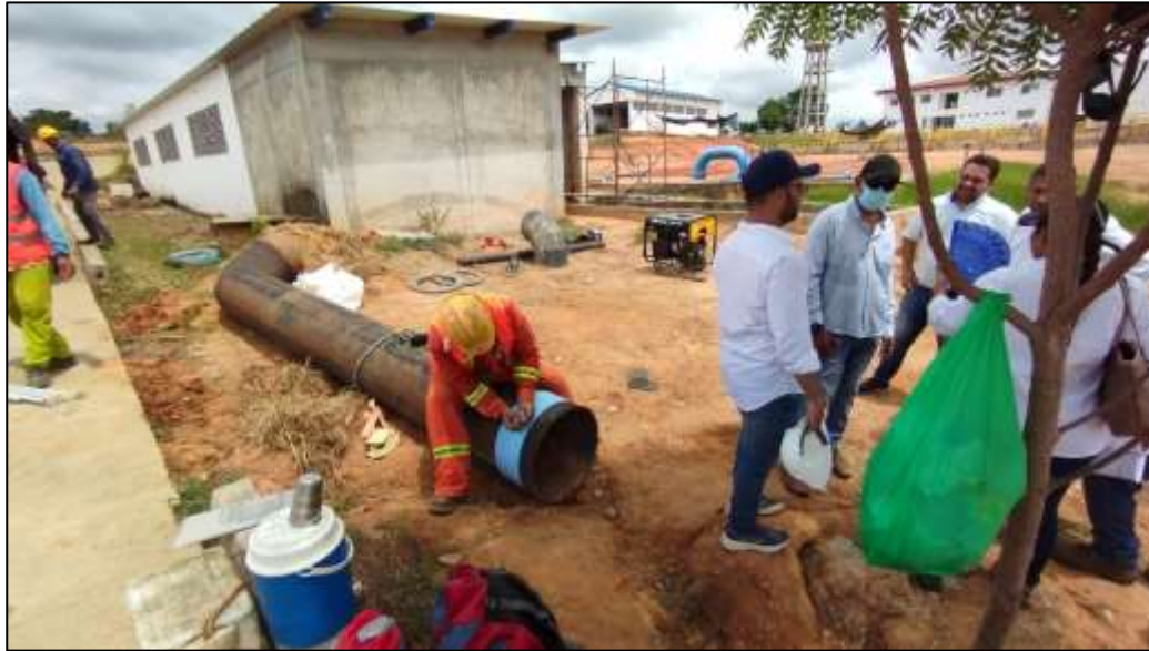
Trabajos externos a las estaciones de bombeo para terminar la cámara y generar la conexión faltante entre las bombas y la conducción en la red que va hacia Buena Vista
