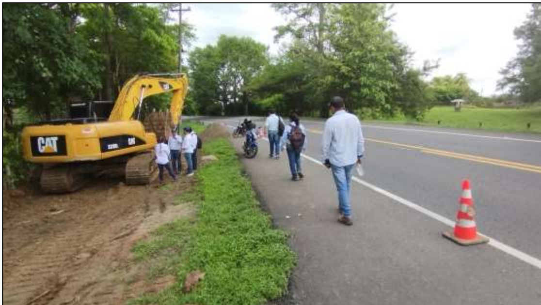
Imagen de la comisión técnica en el punto de trabajo sobre la red de conducción
