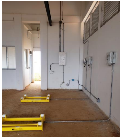
Instalación tuberías a contenedores
