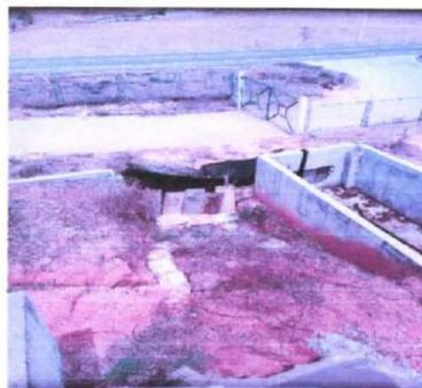
Erosión presentada en talud del edificio de cloración
