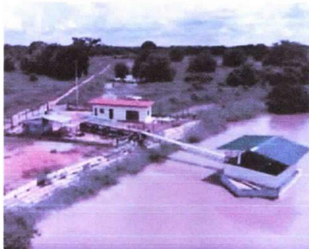
La operación continua con el bombeo del agua hasta una planta de tratamiento convencional PTAP de 390 lps de capacidad, con una longitud 4.6 km, a través de una tubería en HD de 500 mm de diámetro.
