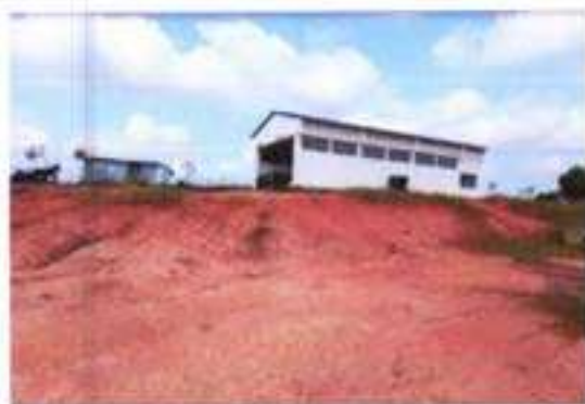
Erosión presentada en talud del edificio de cloración
