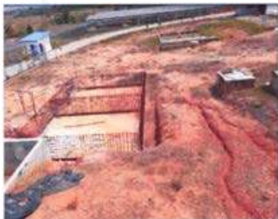
Erosión presentada en talud del edificio de cloración
