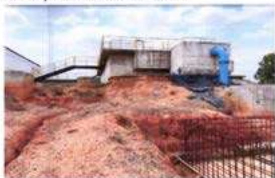
Erosión presentada en Desarenador
