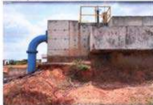
Erosión presentada en Desarenador
